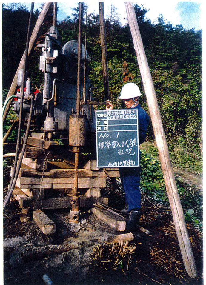
標準貫入試験状況
