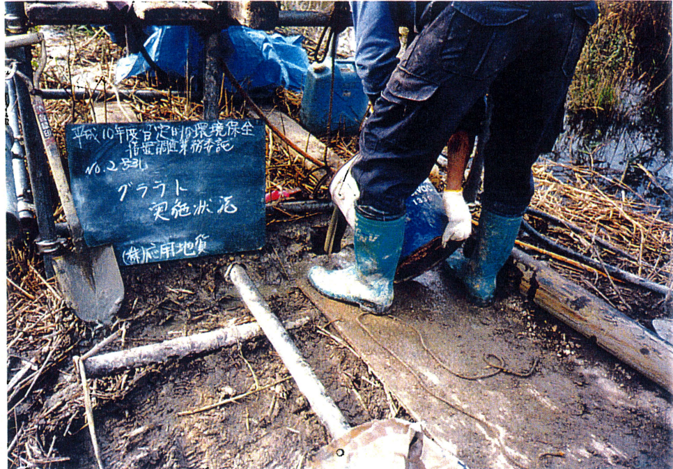
セメントミルク注入状況
