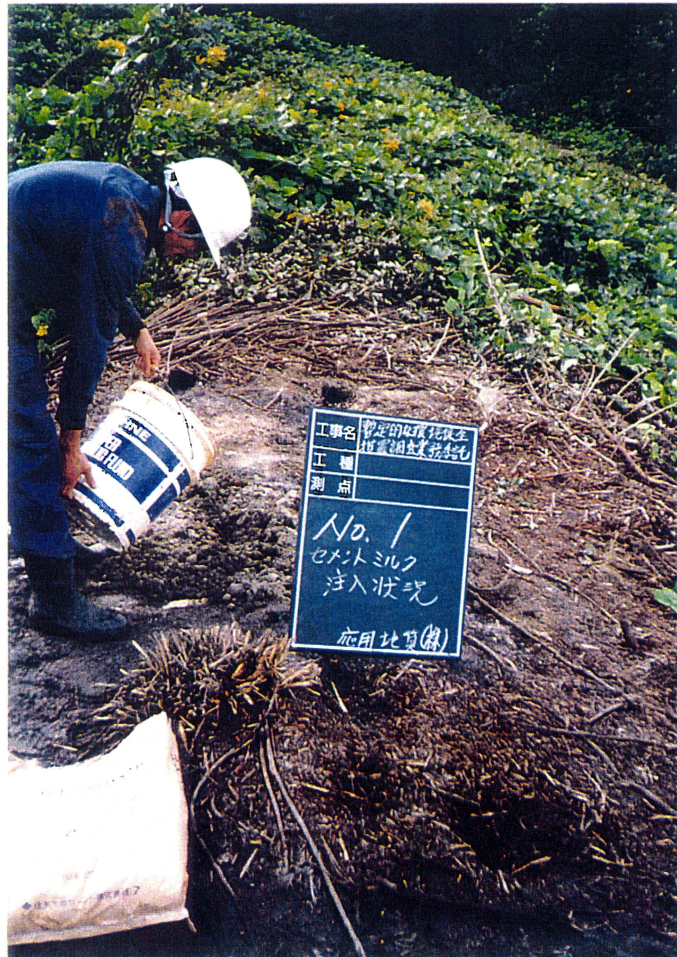
セメントミルク注入状況
